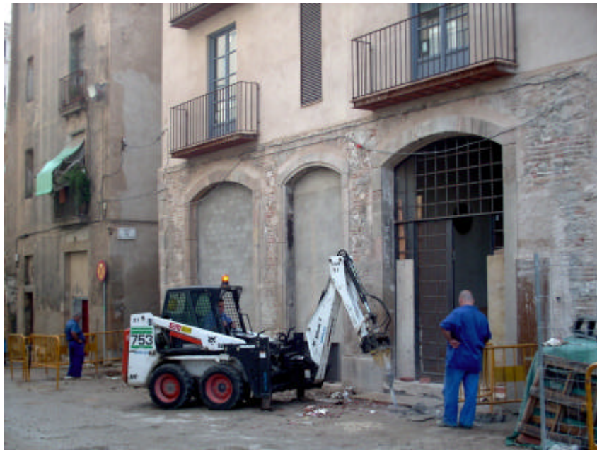
Foto. 1. Excavació amb màquina
