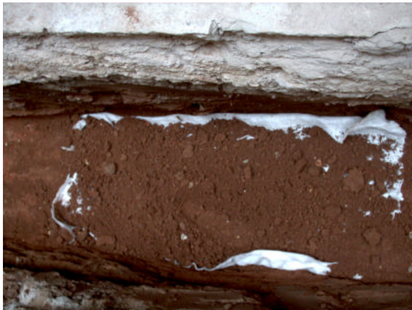
Foto. 7. Protecció de la sitja amb Geotèxtil
